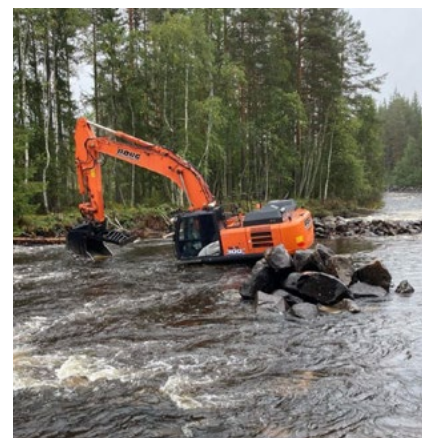
En specialkonstruerad gripgallerskopa på John Borks ZX300LC-7 underlättar arbetet med översvämningsprojektet vid Kårböle.
