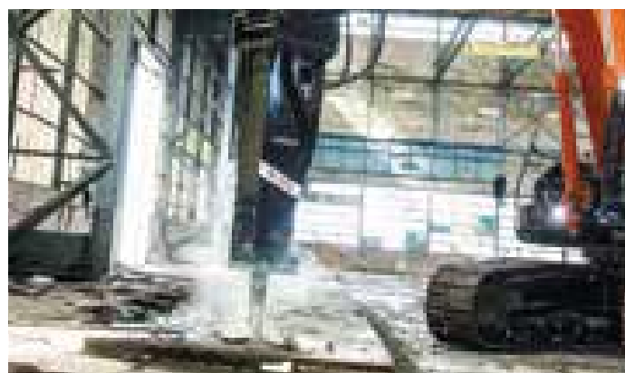
Hitachi-hydraulhammare är lätta och har hög anslagsenergi.
