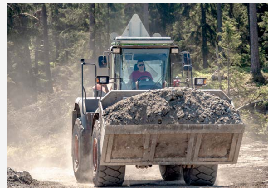
Maskinen har flera år på nacken och går bekymmerfritt på schaktmassedeponin utanför Göteborg.
