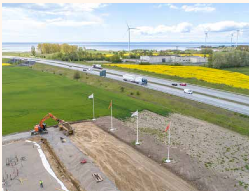
Drönbild på grundläggningsarbetet utanför Landskrona. E6:an i bakgrunden.
