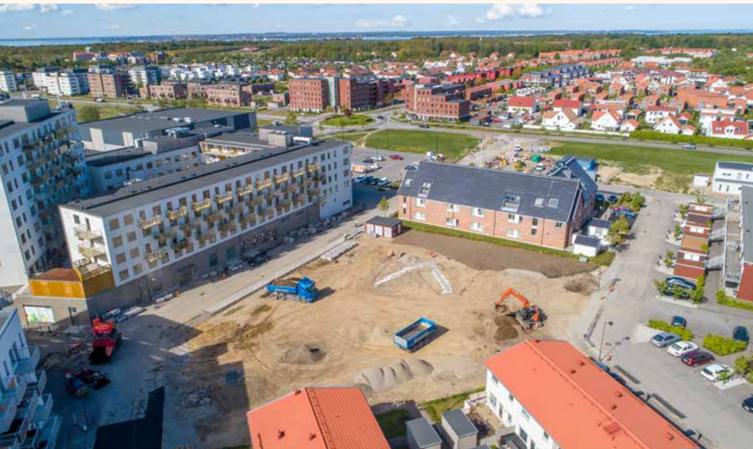
En ZX135USLC gick i våras på anläggningsarbeten i Helsingborg.
