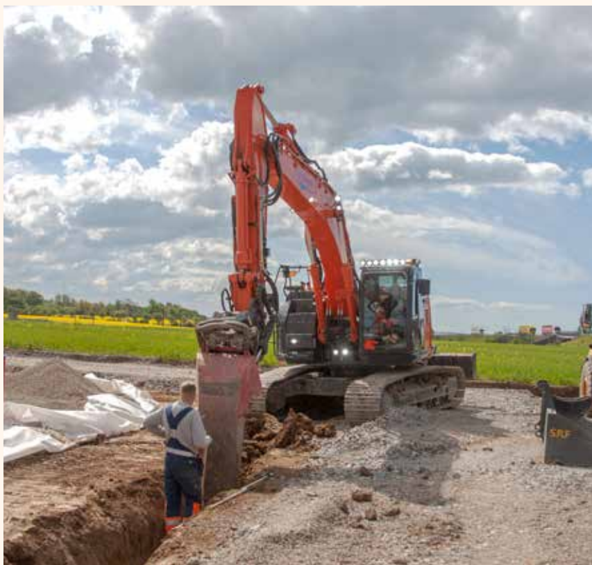
225:an i arbete på grundläggningsarbetet utanför Landskrona.
