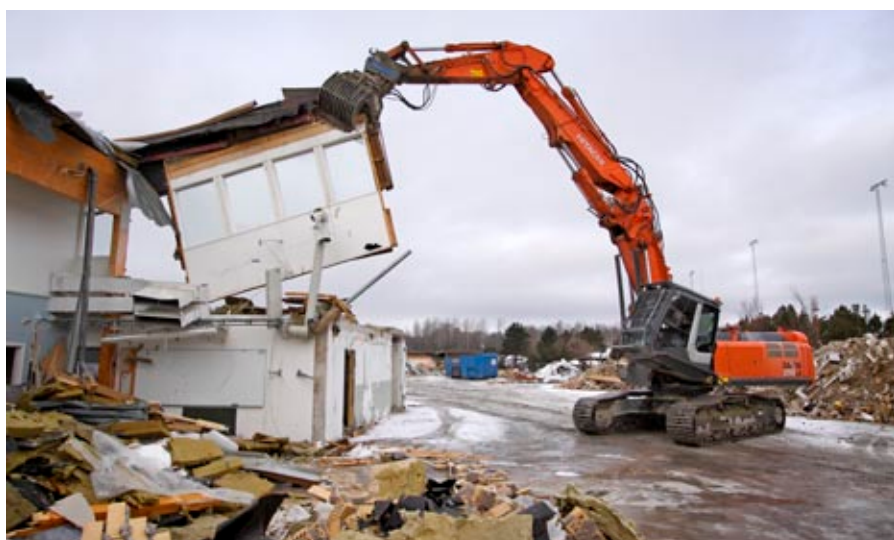
Med demolition-grävare kan skolbyggnaden monteras ned bit för bit. Limträbalken som skymtas till vänster ska återanvändas medan övrigt material återvinns.
