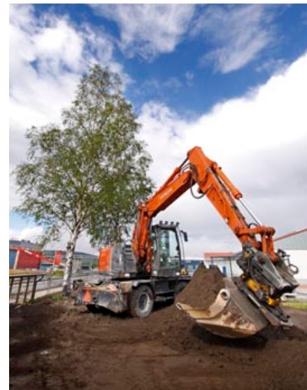
Jan-Erik Skogström och maskinföraren Tord Forsman. Perronger och stationsområdet på Örnsköldsviks nya resecentrum har anlagts av Härnösands Schakt & Trädgårdsanläggningar. Hitachi ZX140WT-3:n är en av företagets två nya Hitachimaskiner.
