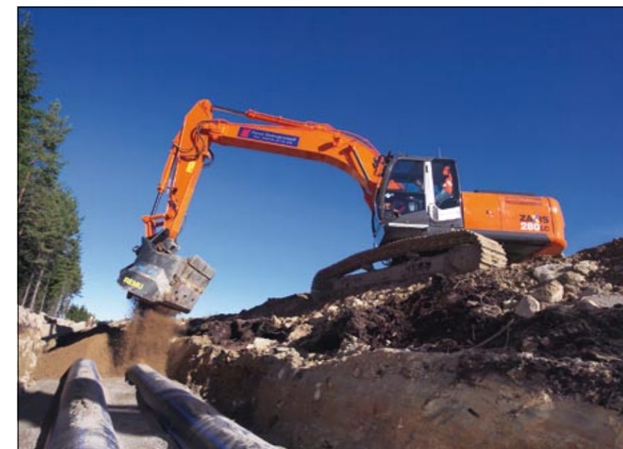
Farm AB:s Hitachi, en ZX 280LC-3, återfyller. Med siktskopen kan allt material som är för grovt siktas bort och delar av schaktmassorna kan på det sättet återanvändas utan att man tullar på kraven när det gäller ledningsbäddens kvalitet.
