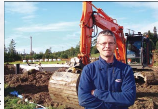
När Ricky Jonsson gräver husgrunder är storleken den rätta med ZX 130, eftersom den jobbar effektivt med både planering och med rena schakter.
