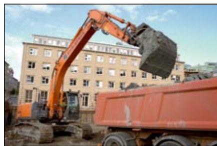
Carlbergs ZX280LC i arbete i Gårda, där företaget utfört markarbetena för ett större husbygge.
